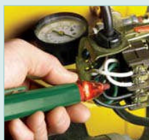
制御盤のトラブル・シュート
