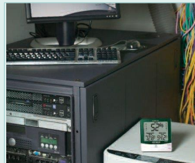
静電気発生条件を発生を保護しコンピューター室での低湿度レベルを警告
