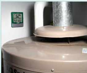
潜在的なカビの成長のために地下室の露点レベルを監視。
